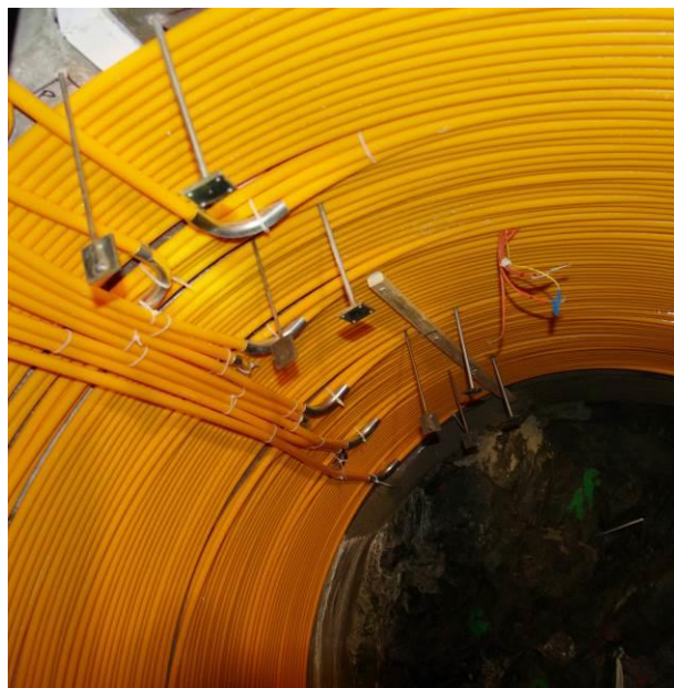
Obrázek 2 – Detail rozmístění topných spirál
