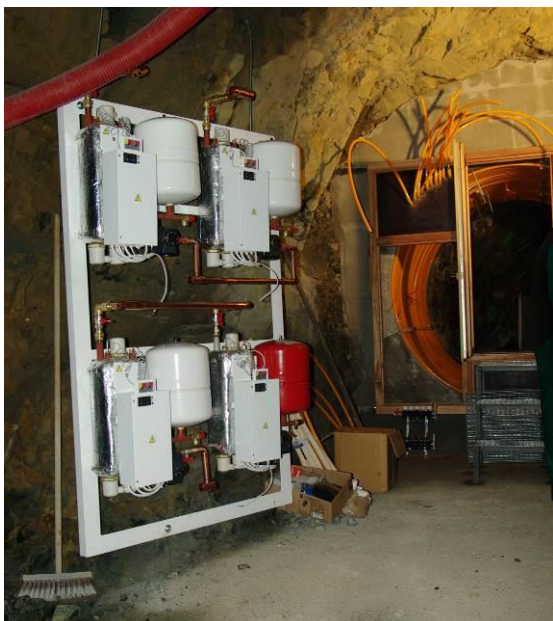
Obrázek 1 – Zapojení topných spirál (oranžové) k elektrokotlům
