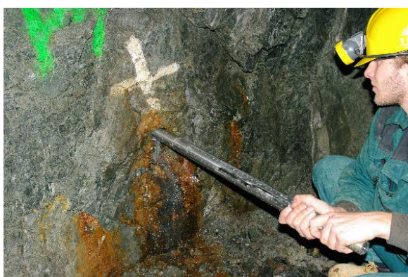
Obrázek 3 – Instalace perforované trubky do vrtu v horninovém masivu
